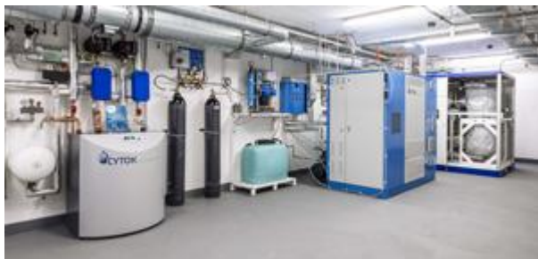
Bild 3: Die Referenzanlage von CYTOK am Ferien- und Freizeitgebiet Bernsteinsee (Niedersachsen) mit Elektrolyseur und Methanisierung
